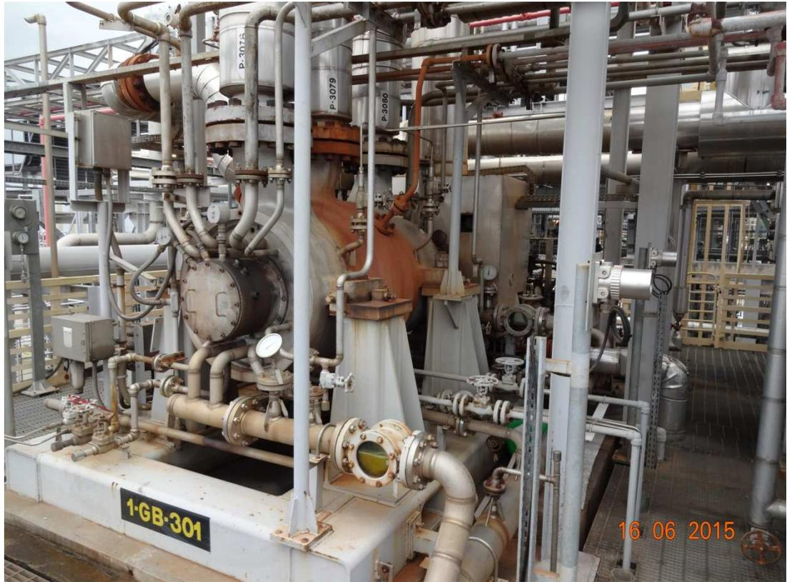
**Figura 15:** Fotografia do Compressor 1-GB-301. Fonte: Fotografia retirada na BRASKEM.
